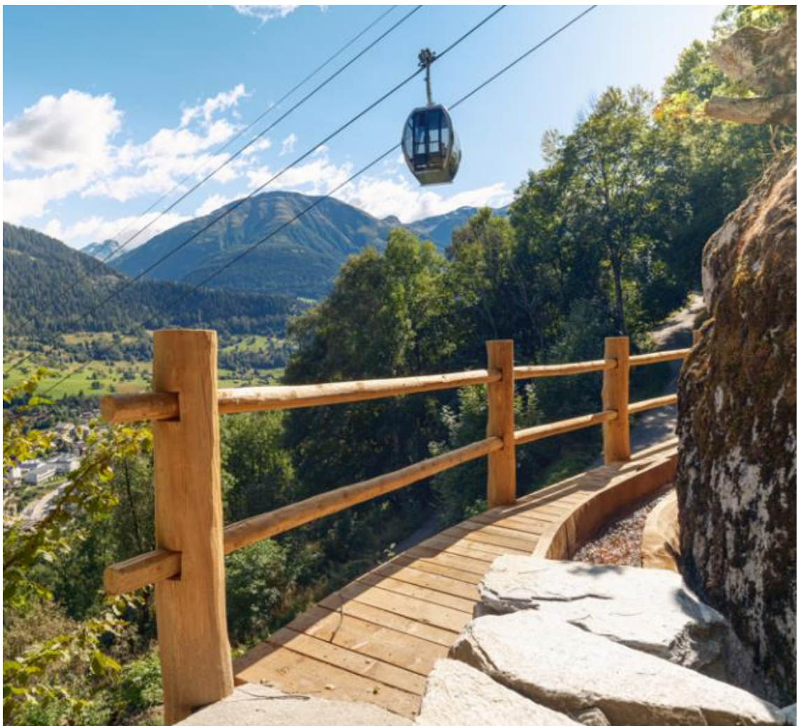
Neuerstellte Wässerwasserleitung mit Holzkännel bei km 3.5 / Foto Forst Aletsch
